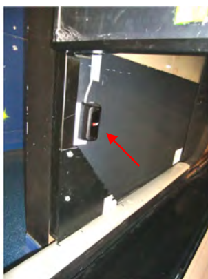
Abb. 1: Lichtschranke über 2 Bahnen
