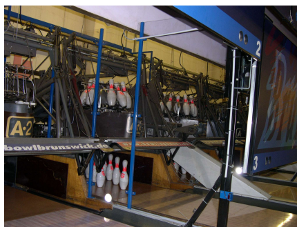
Trennwände zwischen jeweils zwei Pinsettern
