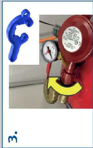
Jetzt mit der Hand Druckregeleinrichtung abschrauben – rechts herum drehen, keine Zange benutzen
