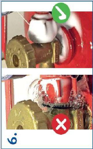
Am Schloss immer kontrollieren, ob der Anschluss dicht ist – der aufgesprühte Schaum darf keine Blasen werfen
