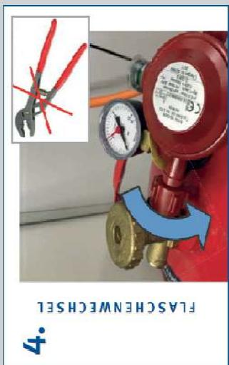
Druckregeleinrichtung mit der Hand fest-schrauben – linksherum drehen, keine Zange benutzen
