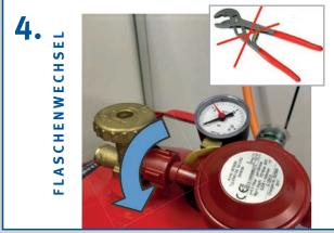
Druckregeleinrichtung mit der Hand festschrauben – linksherum drehen, keine Zange benutzen
