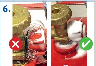
Am Schluss immer kontrollieren, ob der Anschluss dicht ist – der aufgesprühte Schaum darf keine Blasen werfen
