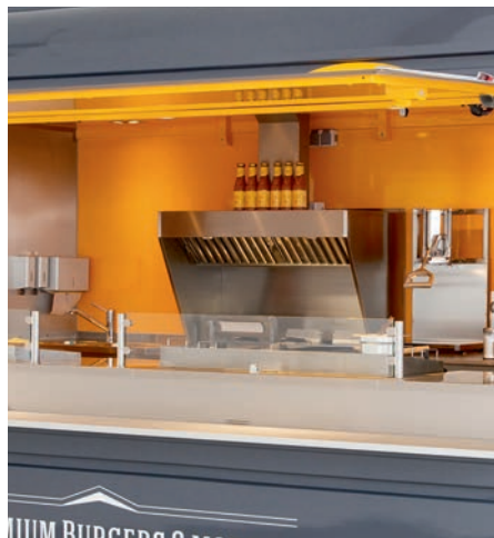
Abbildung 4: Beispiel für einen Spuckschutz. Form und Größe sind gemäß den Hygieneanforderungen festzulegen.
