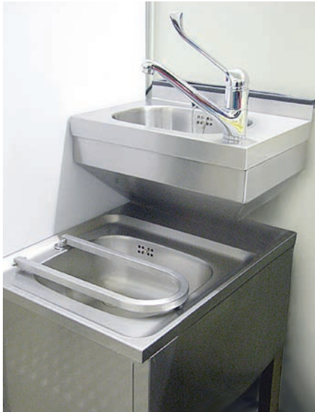
Abbildung 7: Gute Lösung: Oben das Waschbecken für die Händereinigung, darunter ein gesonderter Ausguss.
