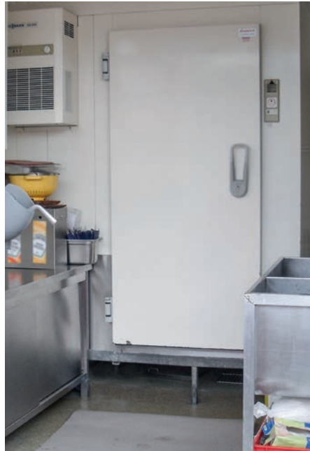
Abbildung 15: Mobile Kühlzelle mit Vorraum
