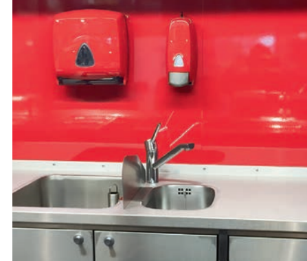
Abbildung 6: Doppelbecken zur Trennung von Spül- und Handwaschbereich in einer kleinen Betriebsstätte.
