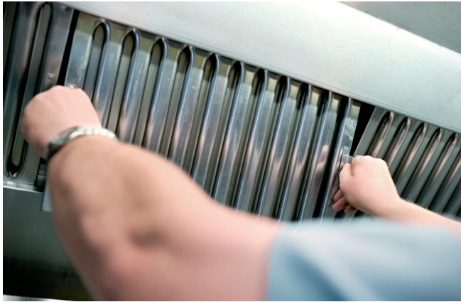
Abb. 9: Flammschutzfilter (Aerosolabscheider)
