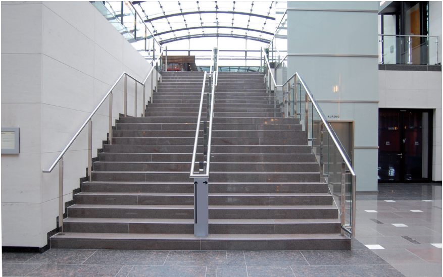
Abb. 7: Treppe mit zusätzlichem Zwischenhandlauf
