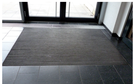
Abb. 5: Schmutzfangmatte (Schmutzschleuse) bodengleich verlegt
