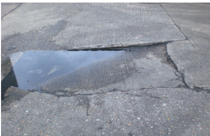
Abb. 1 und 2: Rutsch- und Stolpergefahr - Unebenheiten in Fußböden und Wasserlachen sind oft die Auslöser von Unfällen
